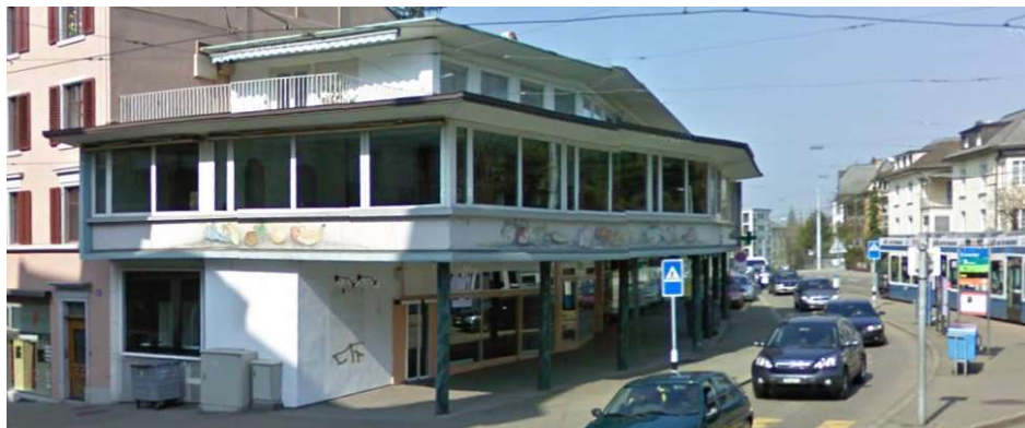
Ehem. Rest. Römerhof, Asylstr. 60, 8032 Zürich (2009)
